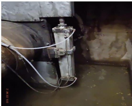
Foto 25 water in betonput, corrosie leiding, corrosie schuifklep, aantasting netwerkmodule/elektronica.
