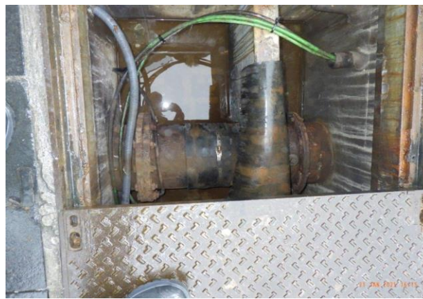
Foto 35 water in betonput, corrosie leiding, corrosie schuifklep, aantasting netwerkmodule/elektronica.
