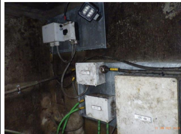
Foto 33 water in betonput, corrosie leiding, corrosie schuifklep, aantasting netwerkmodule/elektronica.
