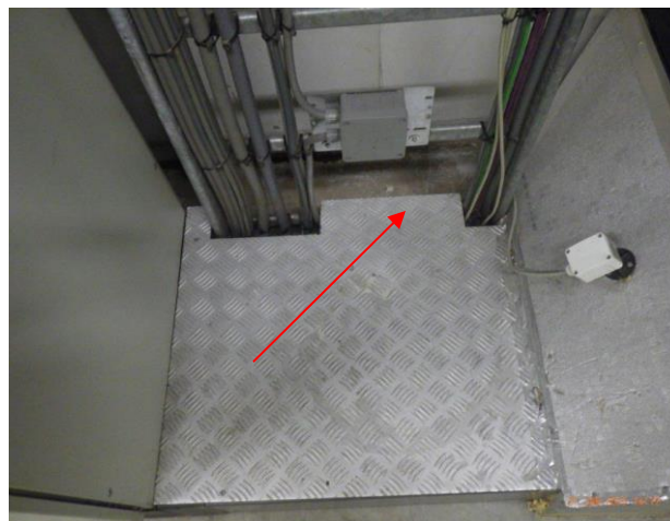
Foto 43 luchtverlies van koelunit naar regelkasten.
