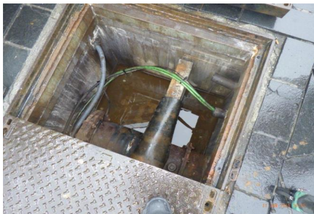
Foto 34 water in betonput, corrosie leiding, corrosie schuifklep, aantasting netwerkmodule/elektronica.
