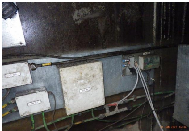
Foto 29 water in betonput, corrosie leiding, corrosie schuifklep, aantasting netwerkmodule/elektronica.
