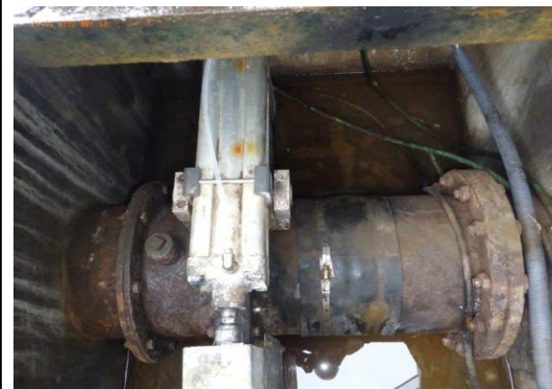
Foto 36 water in betonput, corrosie leiding, corrosie schuifklep, aantasting netwerkmodule/elektronica.
