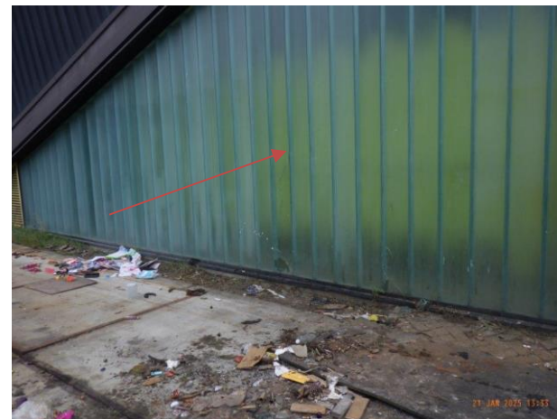
Foto 6 glas defect linker zijkant.
