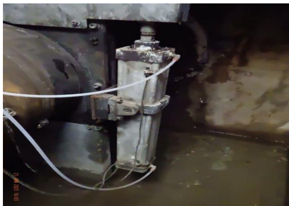
Foto 28 water in betonput, corrosie leiding, corrosie schuifklep, aantasting netwerkmodule/elektronica.
