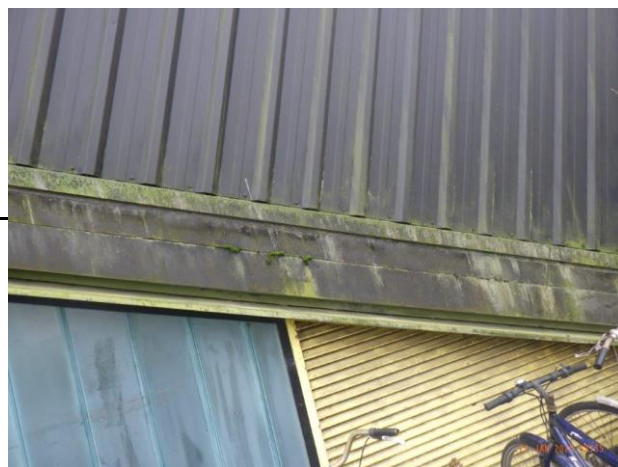
Foto 3502 buitenzijde gebouw vervuiling en corrosie.
