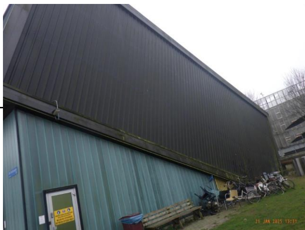
Foto 3501 buitenzijde gebouw vervuiling en corrosie.
