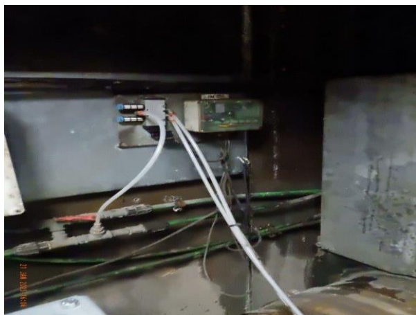
Foto 31 water in betonput, corrosie leiding, corrosie schuifklep, aantasting netwerkmodule/elektronica.
