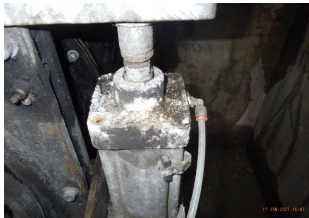
Foto 26 water in betonput, corrosie leiding, corrosie schuifklep, aantasting netwerkmodule/elektronica.
