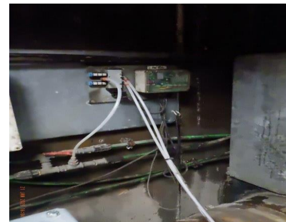
Foto 30 water in betonput, corrosie leiding, corrosie schuifklep, aantasting netwerkmodule/elektronica.
