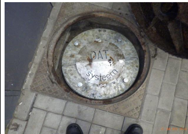
Foto 41 Nieuwe gegalvaniseerde deksels, bouten en pakkingen vervangen (150 stuks).
