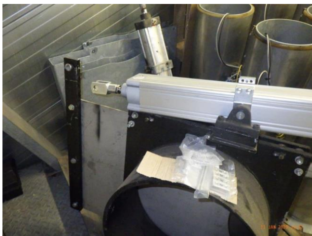
Foto 22 Nieuwe pneumatische aandrijvingen
