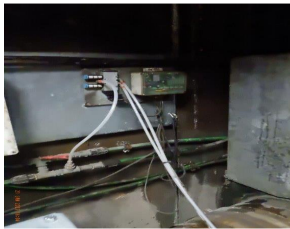
Foto 32 water in betonput, corrosie leiding, corrosie schuifklep, aantasting netwerkmodule/elektronica.
