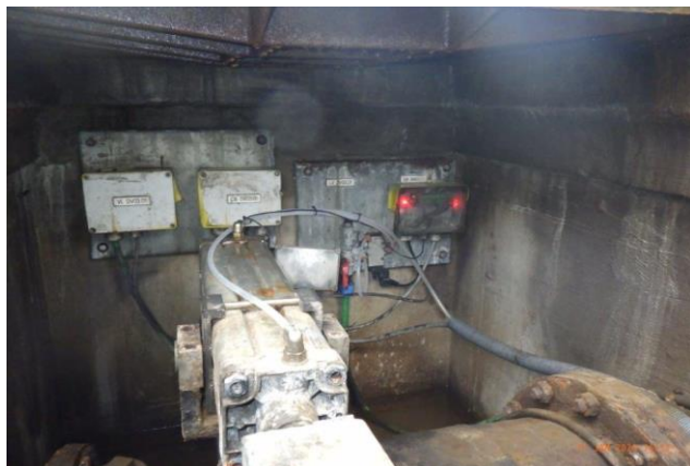
Foto 37 water in betonput, corrosie leiding, corrosie schuifklep, aantasting netwerkmodule/elektronica.
